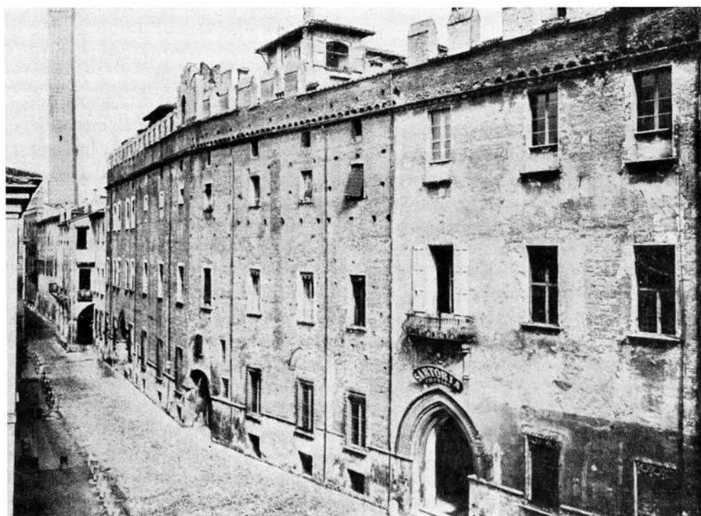
Fig. 1 - Palazzo Pepoli in via Castiglione a Bologna prima del restauro di questo secolo che ha ripristinato le bifore gotiche. Si noti la grandiosità di impianto della costruzione, ricca di sottarchi e cortili interni.
